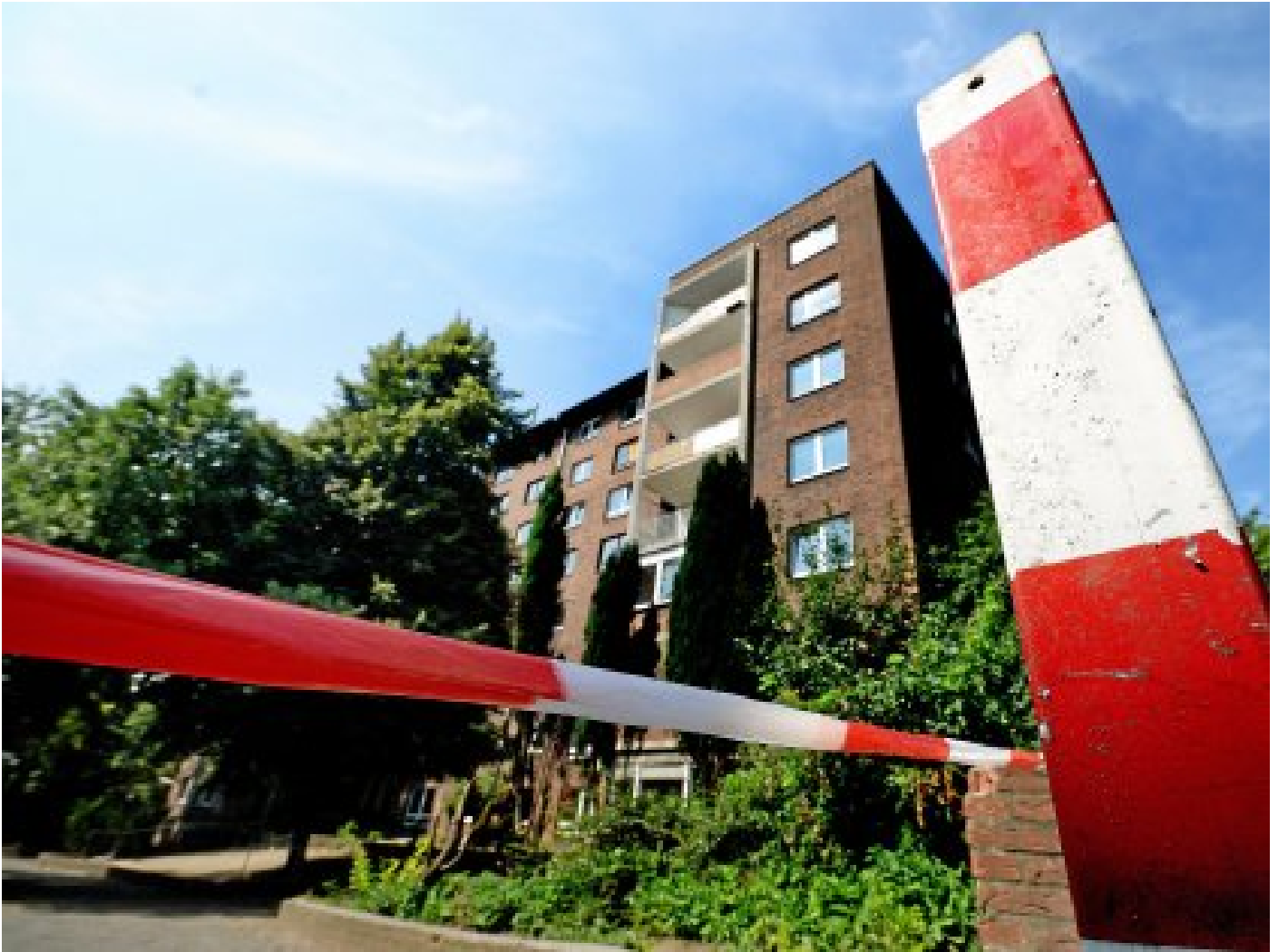
Das Duisburger Problemhaus „In den Peschen“ nach der Räumung im Jahr 2016. Mehr als 1000 Roma hatten hier zwischenzeitlich gelebt.
